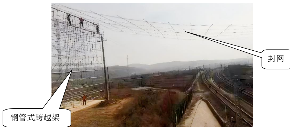
图 3.1-1 本线路工程临时跨越方式施工影像示例
