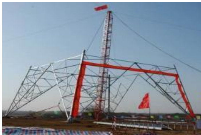
图 3.1-2 线路工程铁塔组立现场影像示例
